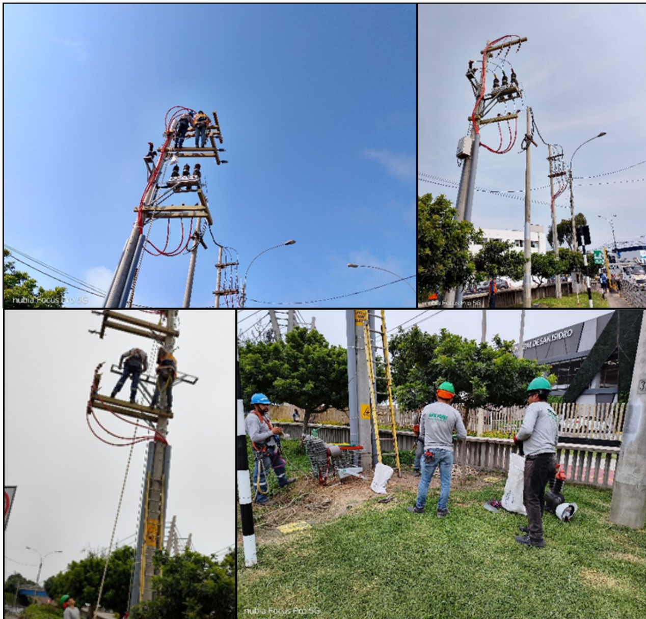
SUMINISTRO Y MONTAJE ELECTROMECHANICO DE EQUIPOS DE PROTECCION RECLOSER
