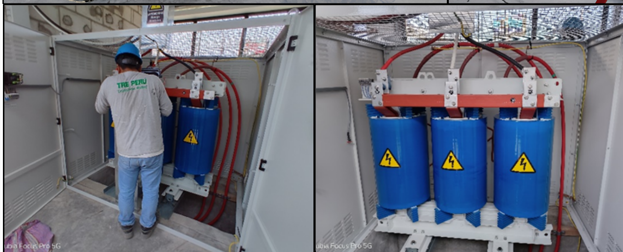
SUMINISTRO Y MONTAJE ELECTROMECHANICO DE SUBSTACION CONVENCIONAL DE 400KVA, 10-20/0.23KV
